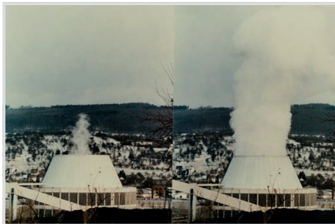
Bild 8. Hybrid-Rundkühlturm des Kraftwerkes Altbach im Nassbetrieb (rechts) und im Hybridmodus (links).
