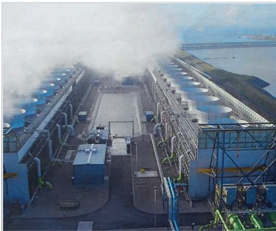
Bild 9. Zellenkühltürme des Kraftwerkes Killingholm, UK: Linke Kühlturmreihe im Nassbetrieb, rechte Kühlturmreihe im Hybridbetrieb.
